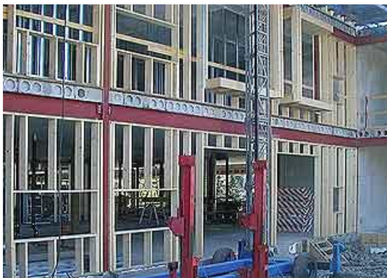
Bruk av bindingsverk av tre og tynnplateprofiler av stål som utfyllende, ikke bærende bindingsverksvegger i yttervegger.
